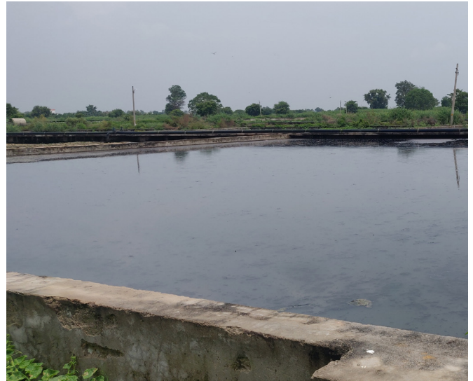
(d) 345 MLD STP at Lucknow, Uttar Pradesh
